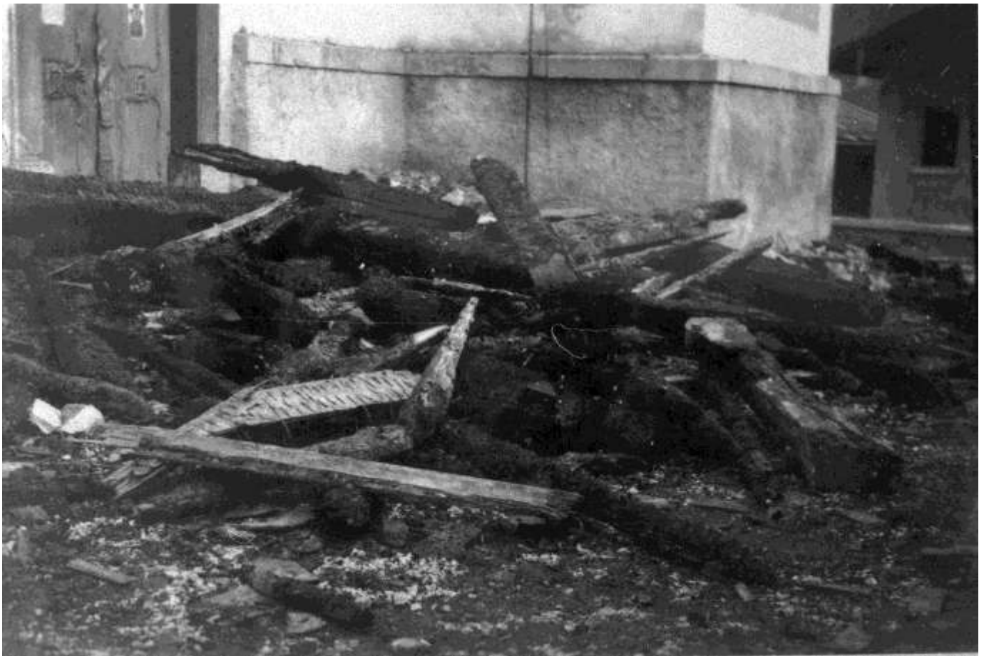
Die Trümmerteile des Dachstuhles liegen um die Kirche .....
