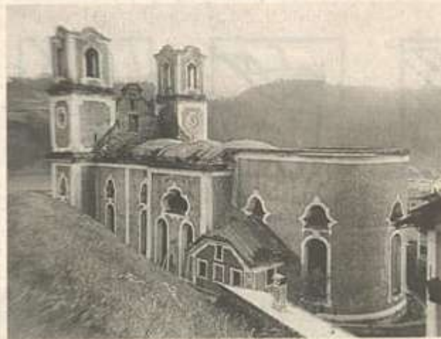
Am Tag danach: Das Gotteshaus gleicht einer Ruine.
