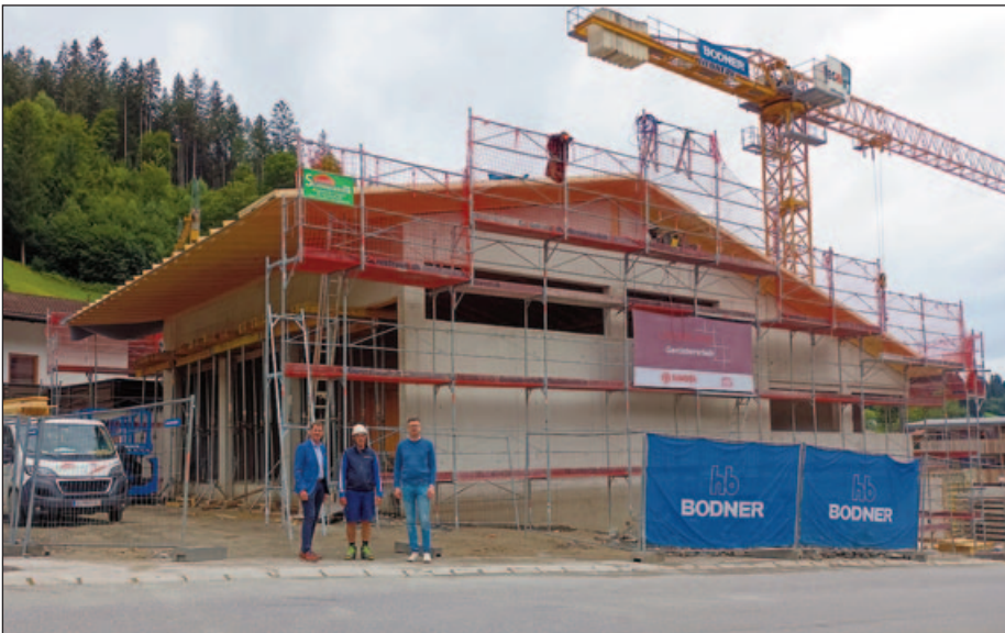
Bgm. Paul Sieberer, Christian Mairhofer (Fa. Bodner) und DI Andreas Hauser vor dem neu erbauten Kelchsauer Mehrzweckgebäude.
