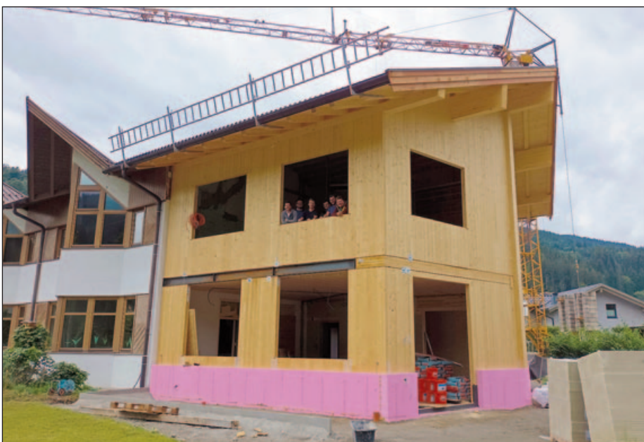
Im Bild (von li. n. re.): Bauleiter Hanspeter Erharter, DI Andreas Hauser und Simon Lindner (Fa. Biedermann), Christoph Gastl (Fa. Gastl), Peter Scherthanner (Fa. Rabl) und Christoph Erharter (Fa. Biedermann)
