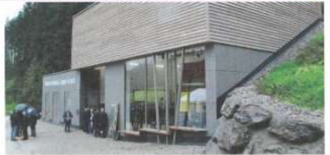
Das Turbinenhaus des Kraftwerkes Langer Grund
