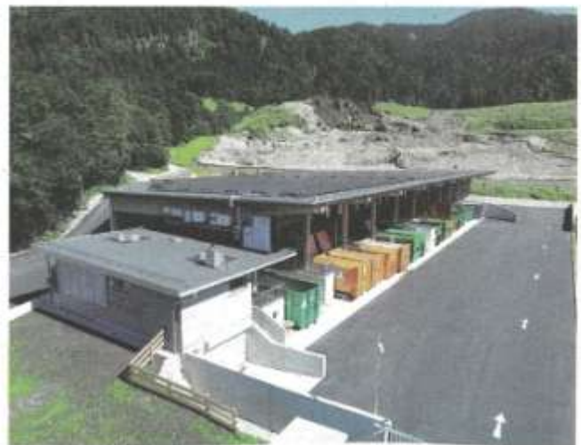
Der neue Recyclinghof Kaiserwinkl ist ein Gemeinschaftsprojekt von Kössen, Schwendt und Walchsee. Foto: Gemeinde Kössen
