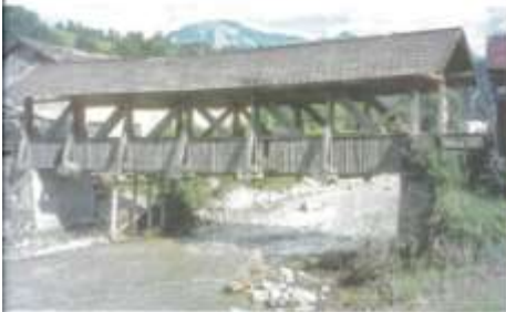
Die „Lücke“ Stegen Brücke Hopfgarten eine hölzerne Brücke wurde im 18. J. von einem Bauern, besonders kleine Ulrich Drexlerbauer erbaut. 1927 baute die Gemeinde zwischen der Holzbrücke und dem Bachlauf, um das alte Dorf zu verbinden und schließlich 1933. Heute verbindet die Holzbrücke die beiden Hopfgarten Land und Markt über die Eisenbahnbrücke. Foto: Archivhistorisches Institut der Universität Wien
