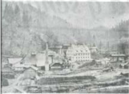
Die Häuser des Dorfes wurden nach dem Bergbau zerstört.
