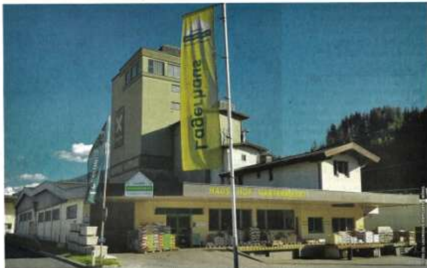
Das Lagerhaus in Hopfgarten mit dem imposanten Silo und der Futtermittelmischproduktion.
