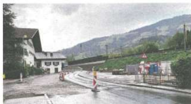
Derzeit wird an der Engstelle beim Ritschareal an der Verbreiterung der Brixentaler Bundesstraße gebaut. Foto: Klausner
