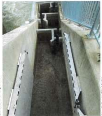
Die Fischtreppe wurde verschüttet. Das Material musste mühevoll per Hand abgetragen werden.
