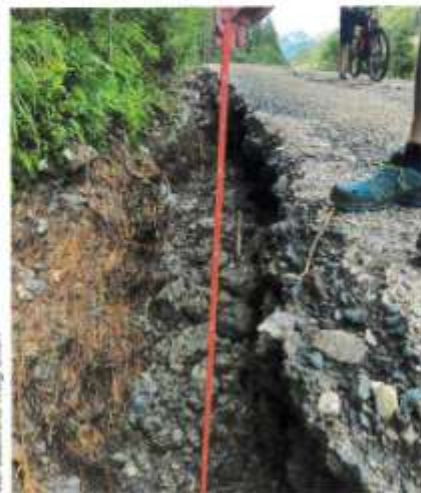
Der Spitzgraben an der Hangseite der Straße wurde bis zu einem Meter vom Wasser ausgewaschen.
