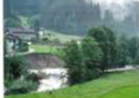
Das Areal in Haidgutten wird intensiv umgebaut...
