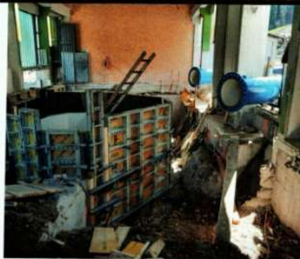
Beim Kraftwerkshaus bleibt kaum ein Stein auf dem anderen.
