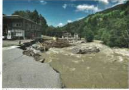
Die bei der Landsturzstelle wurden im Bezirk Kitzbühel zerstört. Die Freizeitanlage wurde zerstört und die Freizeitanlage wurde zerstört.
