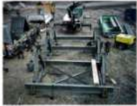
Der Baugrunder und Eisenbetonvermessung der Stützwand des 27 Meter hohen Stützbaus.
