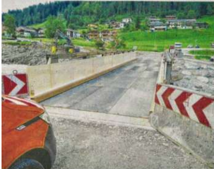
Seit Mittwoch ist die 22 Meter lange Ersatzbrücke über die Kelchsauer Ache einspurig befahrbar.
