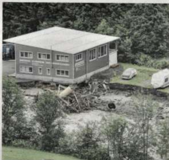
Die Keldsauer Ache hat aufgrund des extrem hohen Wasserstands nicht nur Teile der Keldsauer Landesstraße weggerissen, sondern auch Fahrbahnen und Gebäude wie diese Autowerkstatt angegriffen.
