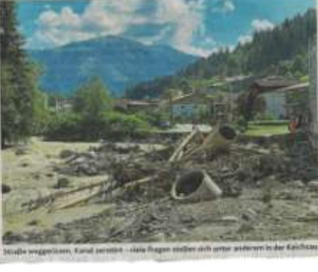
Stöße weggerissen, Kanal zerstört - eine Flut hat sich unter anderem in der Kelchsau
