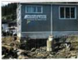
Das Areal in Haidgutten wird intensiv umgebaut...
