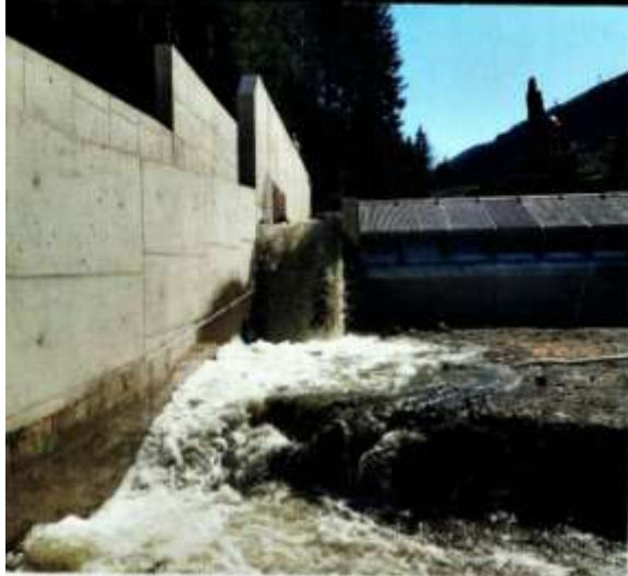
Mittels notwendiger Baumaßnahmen wird das Wasser in die richtigen Bahnen gelenkt.
