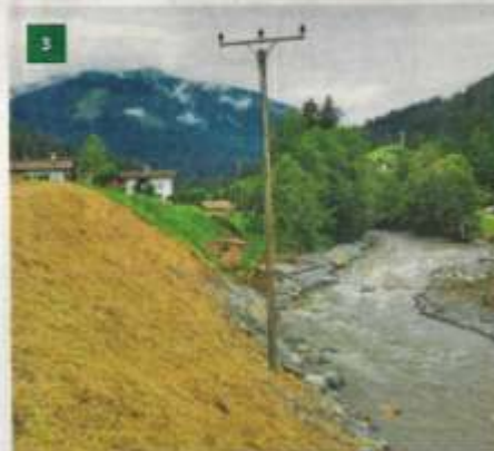
1. Hopfgartens Bürgermeister beim Lokalaugenschein in der Kelchsau. 2. Die Arbeiten an der Landesstraße in die Kelchsau werden noch bis November dauern. 3. Zum Teil musste und muss der Hochwasserschutz neu aufgebaut werden.
