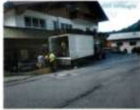
Aufhebung der Leitungsarbeiten an der Föhler.
