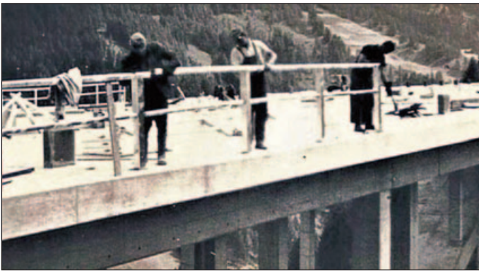
Die Stahlbau - Mander der Fa. Emil Sollerer in der Haslau (heute Stickerei Hirschmann) arbeiteten 1967 auch auf der Brenner-Autobahn (Bildmitte Oberhofer Toni) und setzen Geländer ein.
