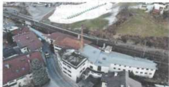
Das Areal der Lederfabrik, nach dem Abriss wird die Straße verlegt
