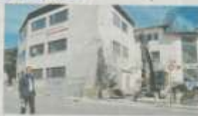
Bgm. Paul Sieberer, Abriss der alten Fabrik. Foto: Brixental
