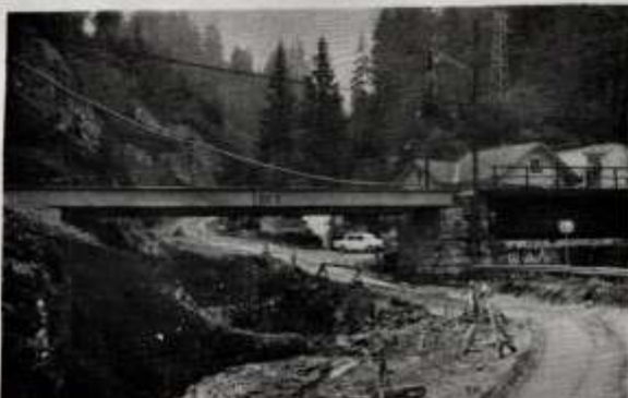
Die Bauarbeiten bei der Bahnunterführung „Windau“ sind im Gange
