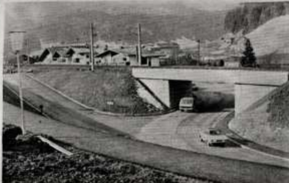
Bahnunterführung „Hopfgarten-Berglift“ 1977 fertiggestellt
