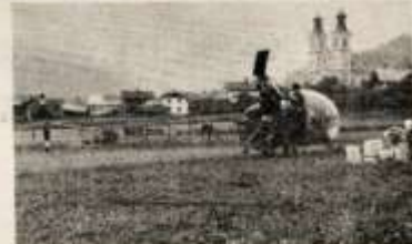
Hochwasserkatastrophe 1959: Hubschrauber des BM f. J. wird beim „Höger-Feld“ anlanden.
