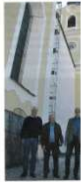
Der Platz wird bereits fertig. Das Bild ist ein Blick auf die Außenrenovierung der Kirche in Hopfgarten. Im Vordergrund sind die Arbeiter und die Baustelle zu sehen.
