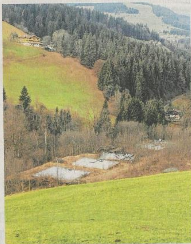
Auf Freiland, wo höchstens etwa Holzstadel errichtet werden dürfen, liegen betonierte Bodenplatten in Hausgröße – laut dem Ortschef konsenslos aus einem früheren Projekt. Auf diesem Areal ist ein Hoteldorf geplant. Foto: Privat
