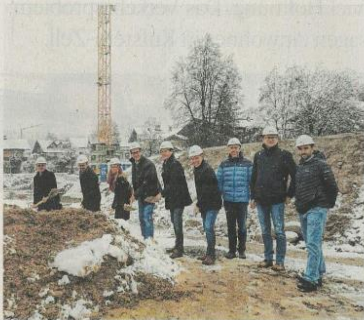
Bürgermeister Paul Sieberer (5. v. r.) und Alpenländische-GF Markus Lechleitner (4. v. l.) mit den Verantwortlichen der Gemeinde, der Alpenländischen und der ausführenden Baufirma beim Spatenstich.
