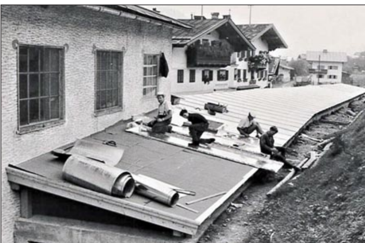
Lagerhalle der Fa. Ritsch wird von der Fa. Hans Tanzer und seinen Mitarbeitern gedeckt.
