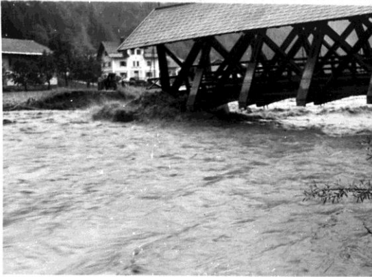
Die Brücke in die Kühle Luft ; im Hintergrund die Anwesen Oberhauser und Luchner
