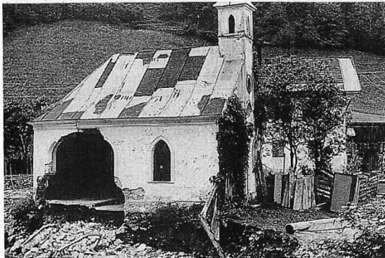
Die zerstörte Kapelle bei Hörbrunn, die abgerissen wurde und an deren Stelle später beim Ausbau der Kelchsauer Landesstraße ein Bildstock errichtet wurde.
