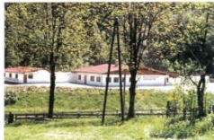
Die neue Schießsportanlage in der Kelchsauer Straße noch mit dem alten Pistolenschießstand
