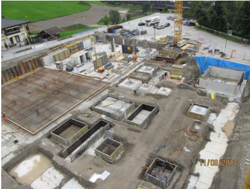
Einschalung und Armierung der Decke für die 1. Parkebene.
