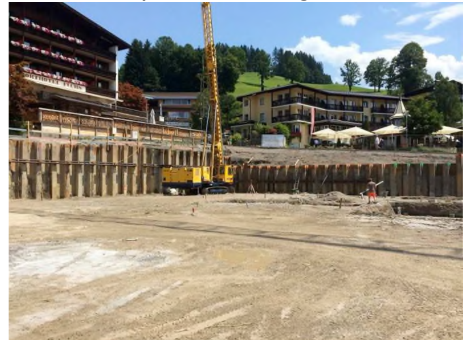
Das Sporthotel wird abgestützt.
