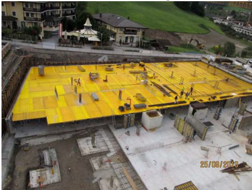
Einschalung und Armierung der Decke für die 1. Parkebene.
