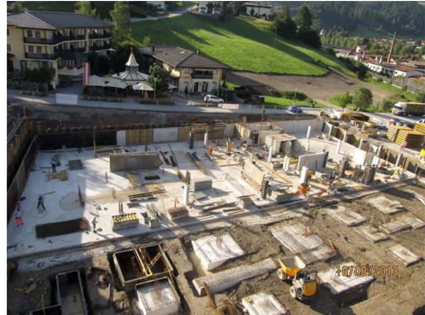
Einschalung und Armierung der Decke für die 1. Parkebene.
