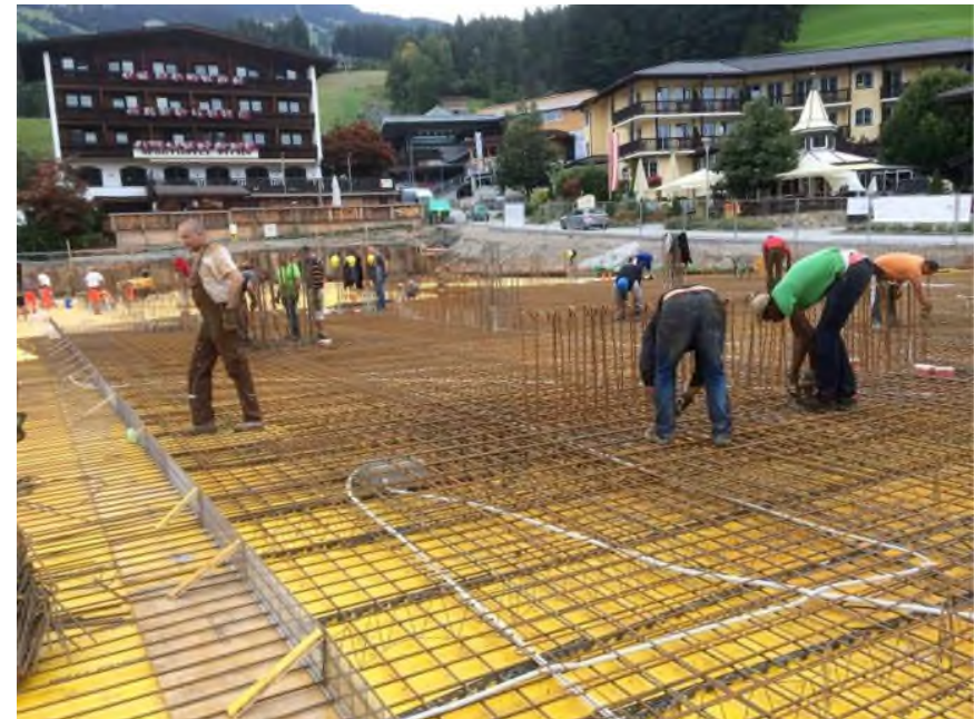
Einschalung und Armierung der Decke für die 1. Parkebene.
