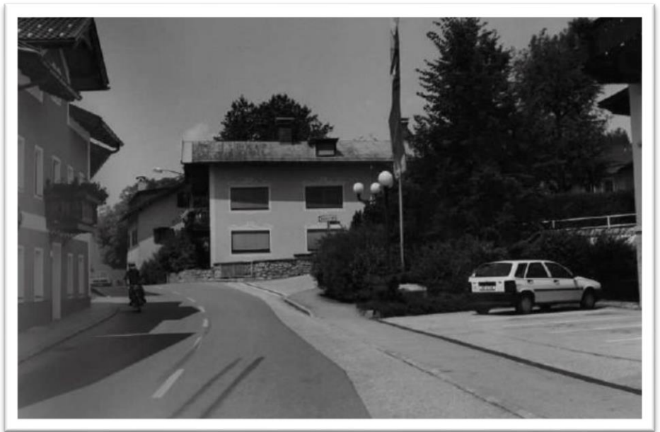
1994: links: UNTERER rechts: RAIFFEISENBANK, HAUS KOBER, NEUSCHMIED
