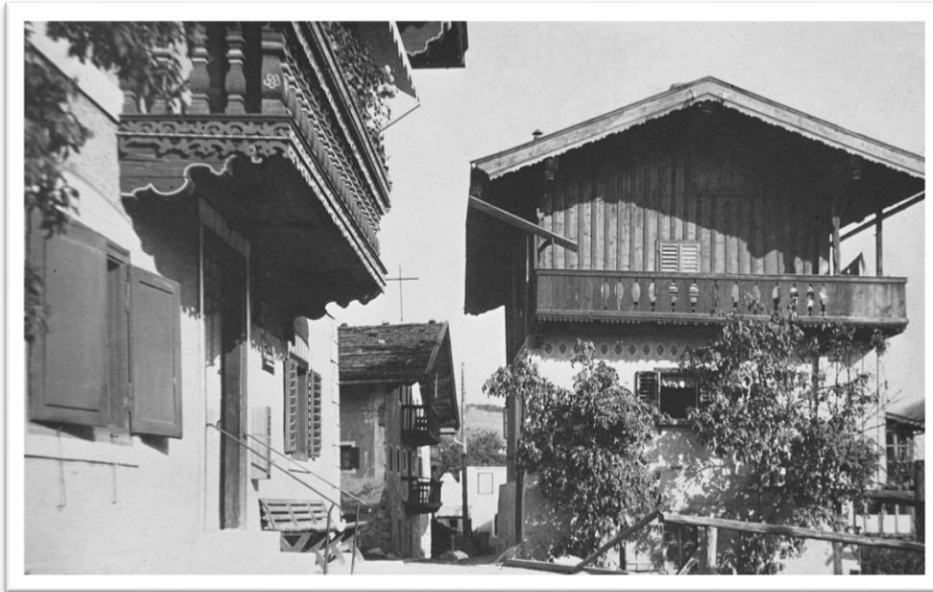
ca. 1920: links: KOBER, LACK rechts: PINTAHÄUSL
